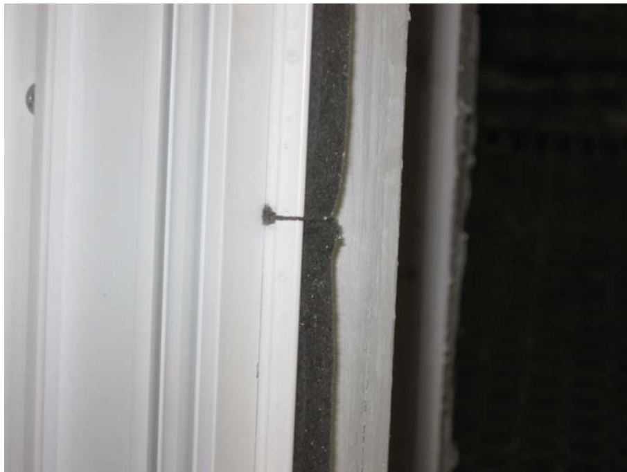
Bild 10 Längsstoßausbildung Variante B nach Ausbau.
