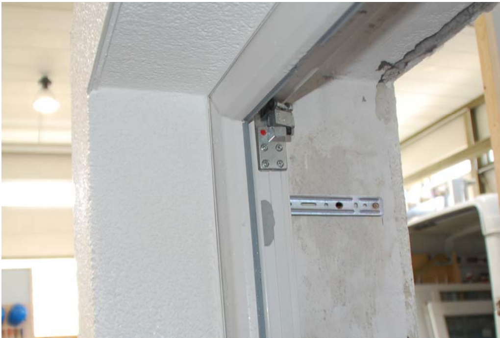
Bild 6 Oberer Eckbereich nach fertig gestelltem WDVS.
