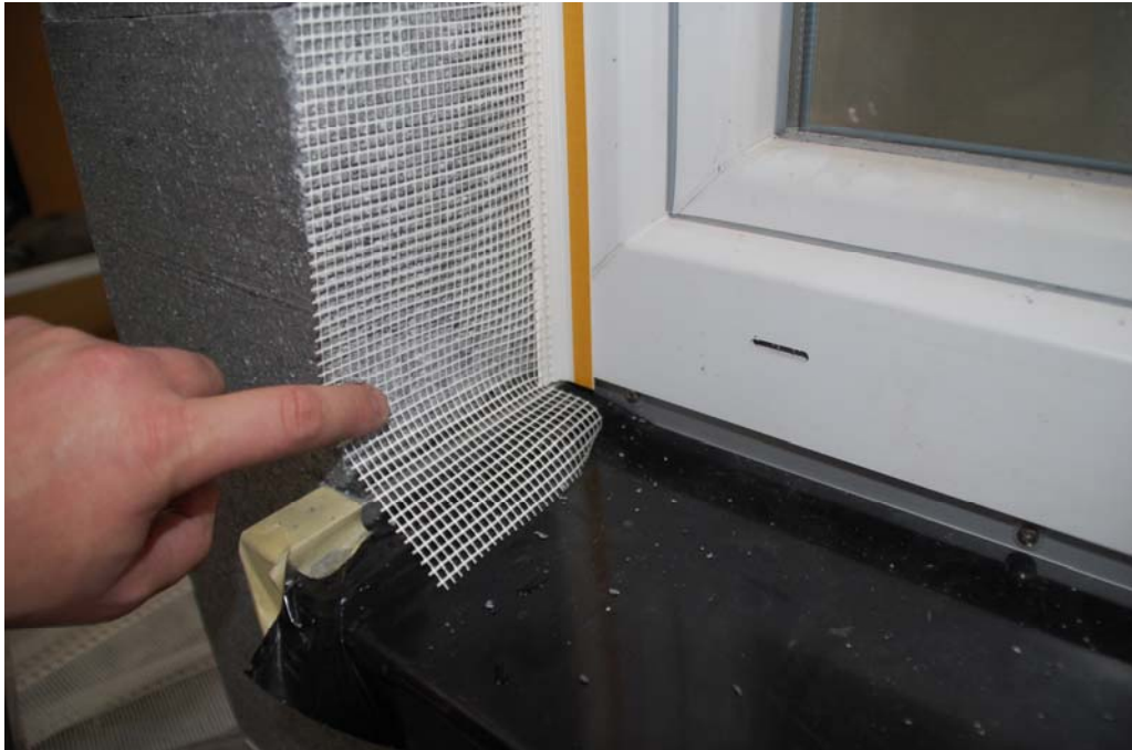
Bild 3 W29-pro APU Gewebeleiste PUR-EX-pro, Ausbildung Übergang zur Fensterbank.
