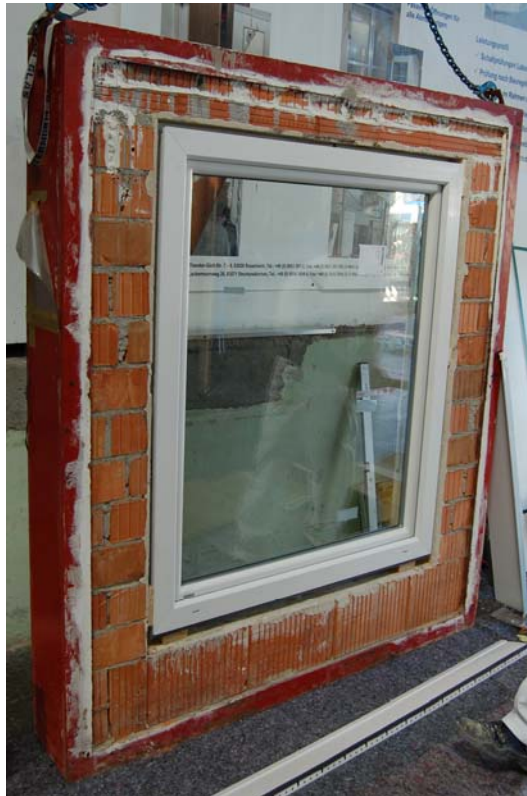
Bild 1 Probekörperherstellung. Im ift vorbereitet: Stahlrahmen mit Ziegelmauerwerk und Kunststofffenster bündig zur Mauerkante gesetzt.
